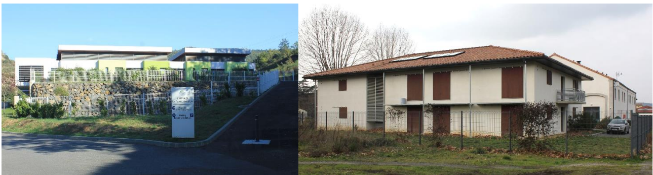
EHPAD Le Pla du Moulin à Couiza et Foyer des Jeunes Travailleurs à Limoux Photographies © AURCA 2017 et 2018
