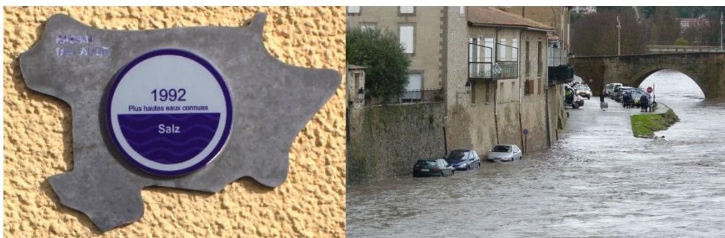
Repère de crue à Couiza / Crue de l'Aude de mars 2017 à Limoux Photographies © AURCA 2017 / webaudetv.com
